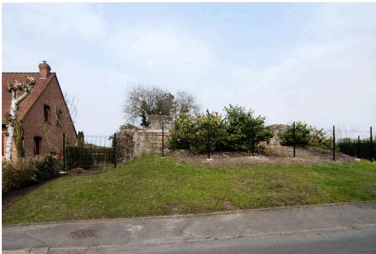
Vue générale vers l'est depuis la rue Delaval
