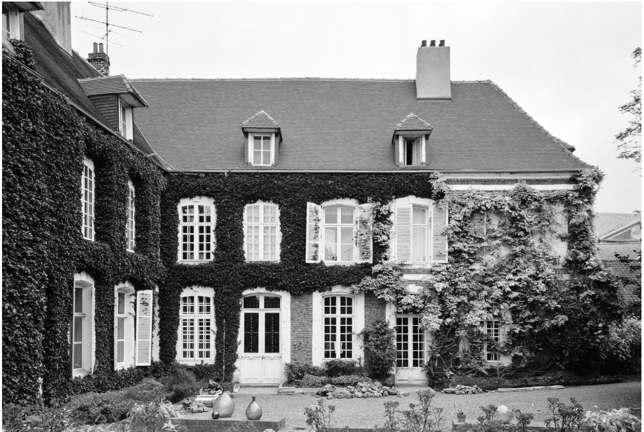
Vue sur jardin. Élévation ouest.
