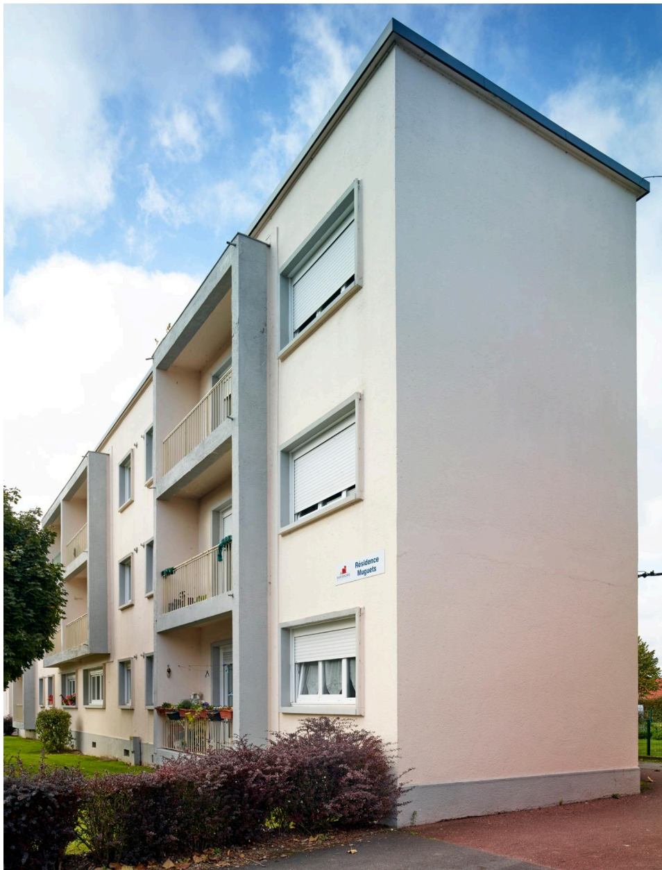
Vue du bloc A côté rue.
