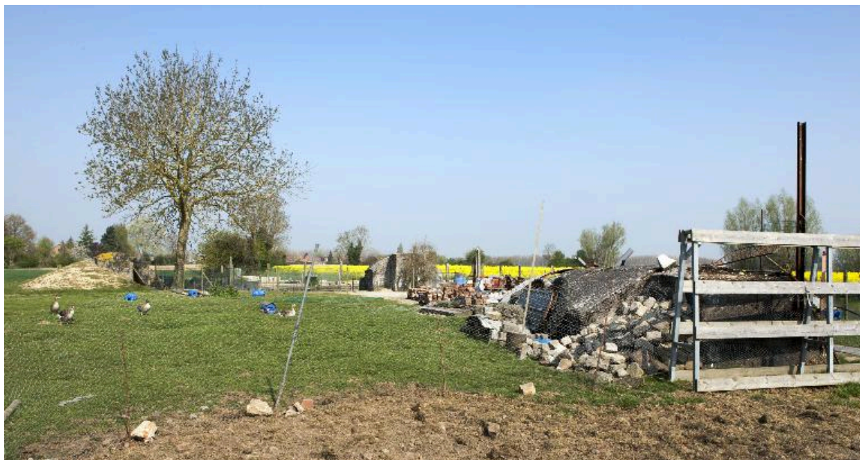
Les trois casemates, vers le nord-ouest
