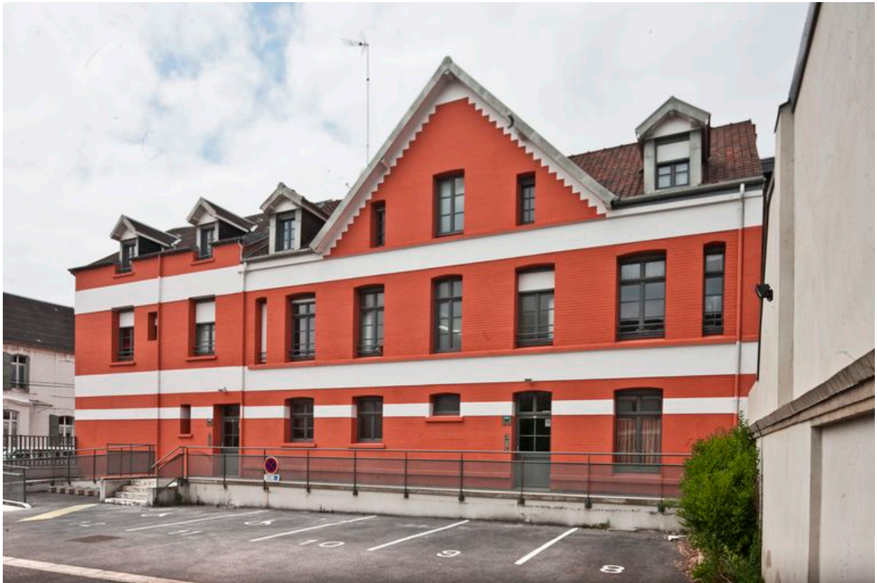
Vue générale de l'élévation postérieure de l'édifice donnant sur la rue Victor-Ménard.
