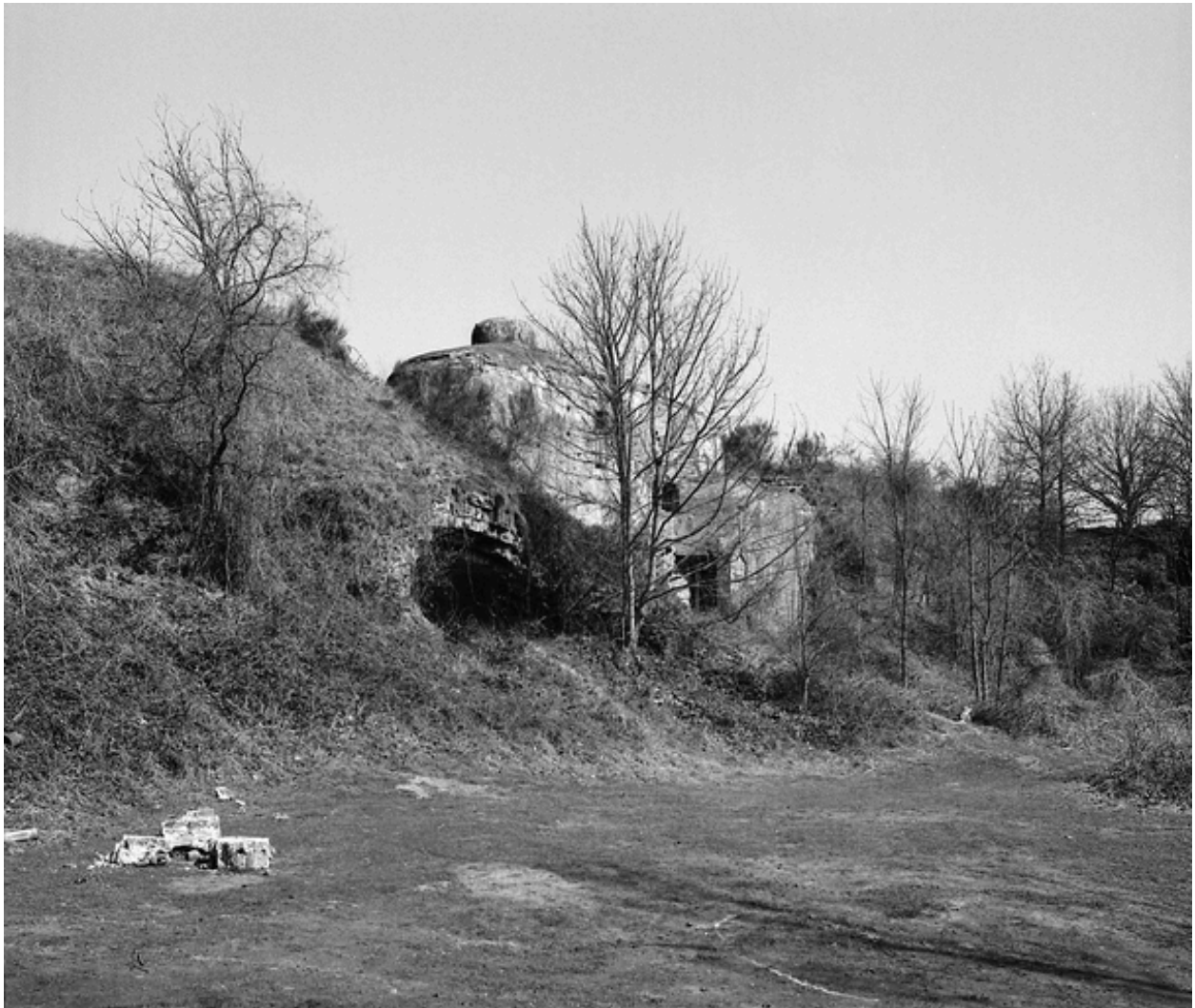
Vue générale de l'aile nord.
