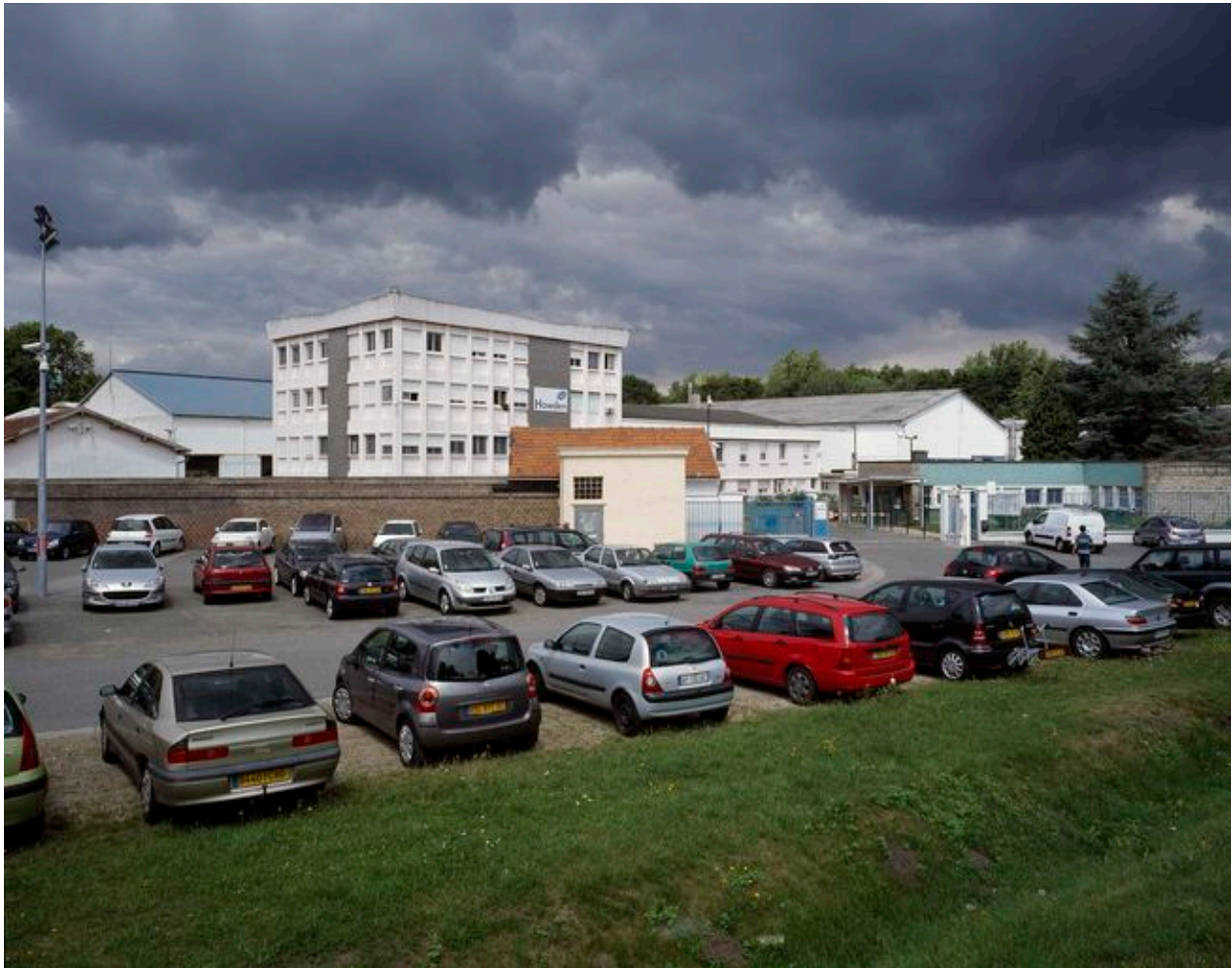
Entrée du site.
