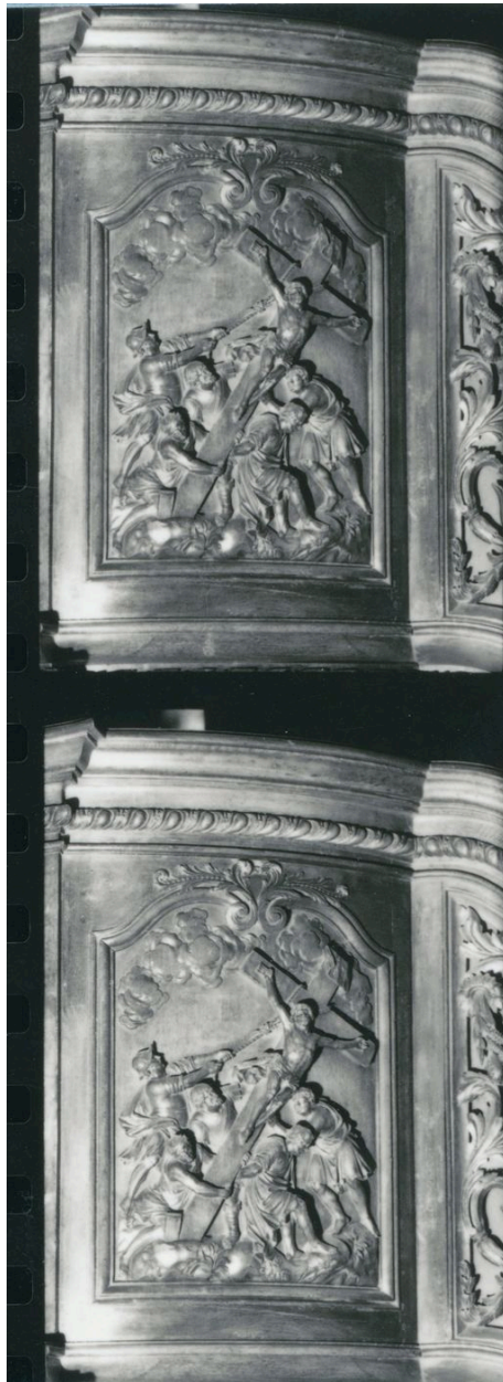
Vue de détail, Elévation de Croix (phot. Wintrebert, 1978, fonds AOA62)
