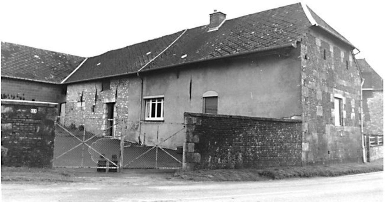
Elévation ouest de l'aile en retour du logis.
