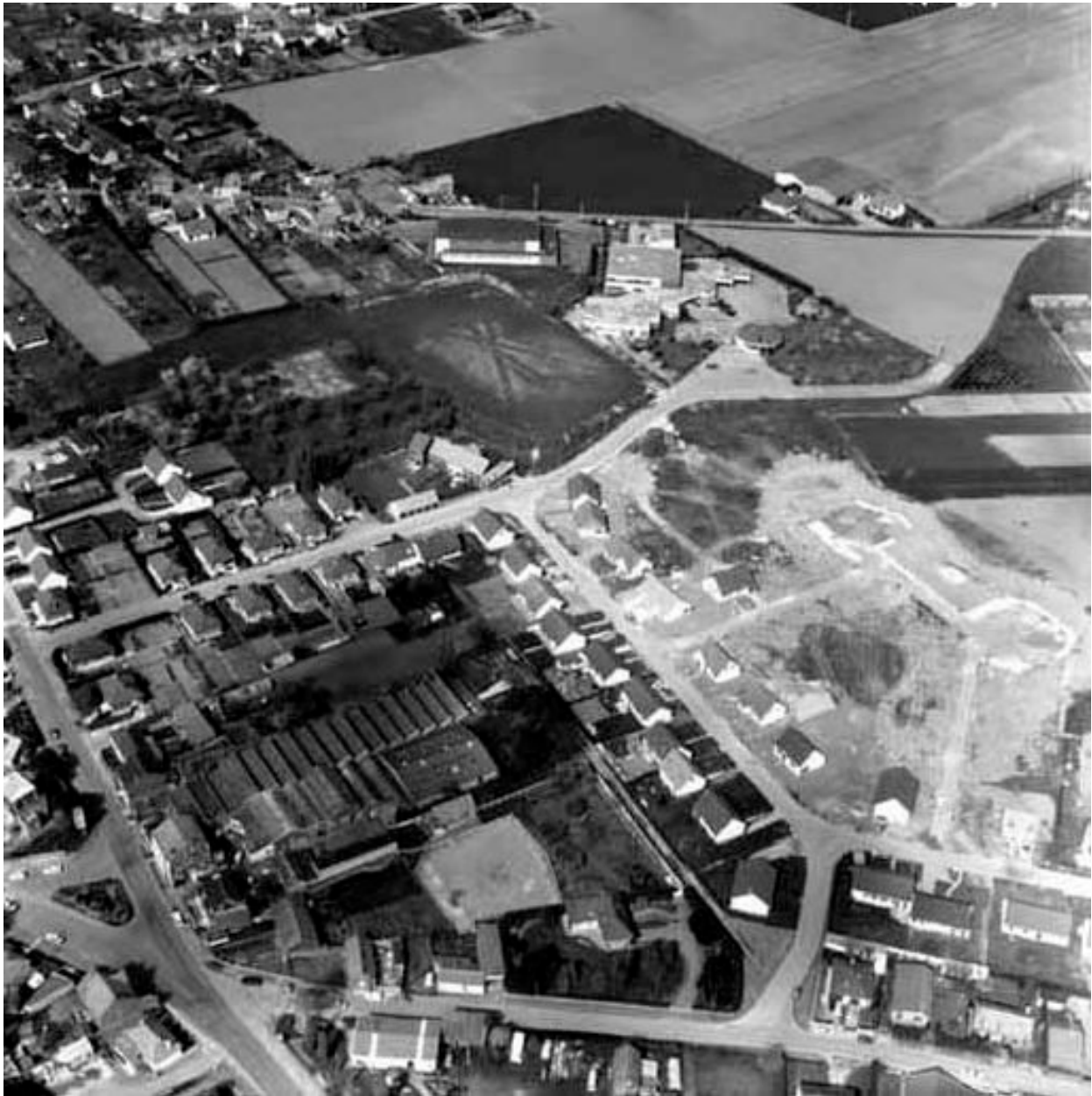
Vue aérienne de l'usine, avec silos.
