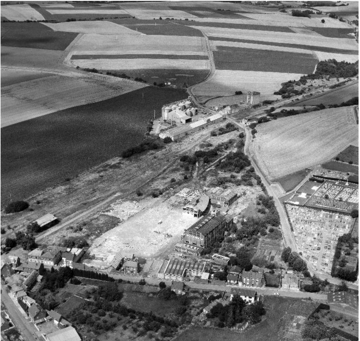
Vue aérienne, flanc sud-ouest.
