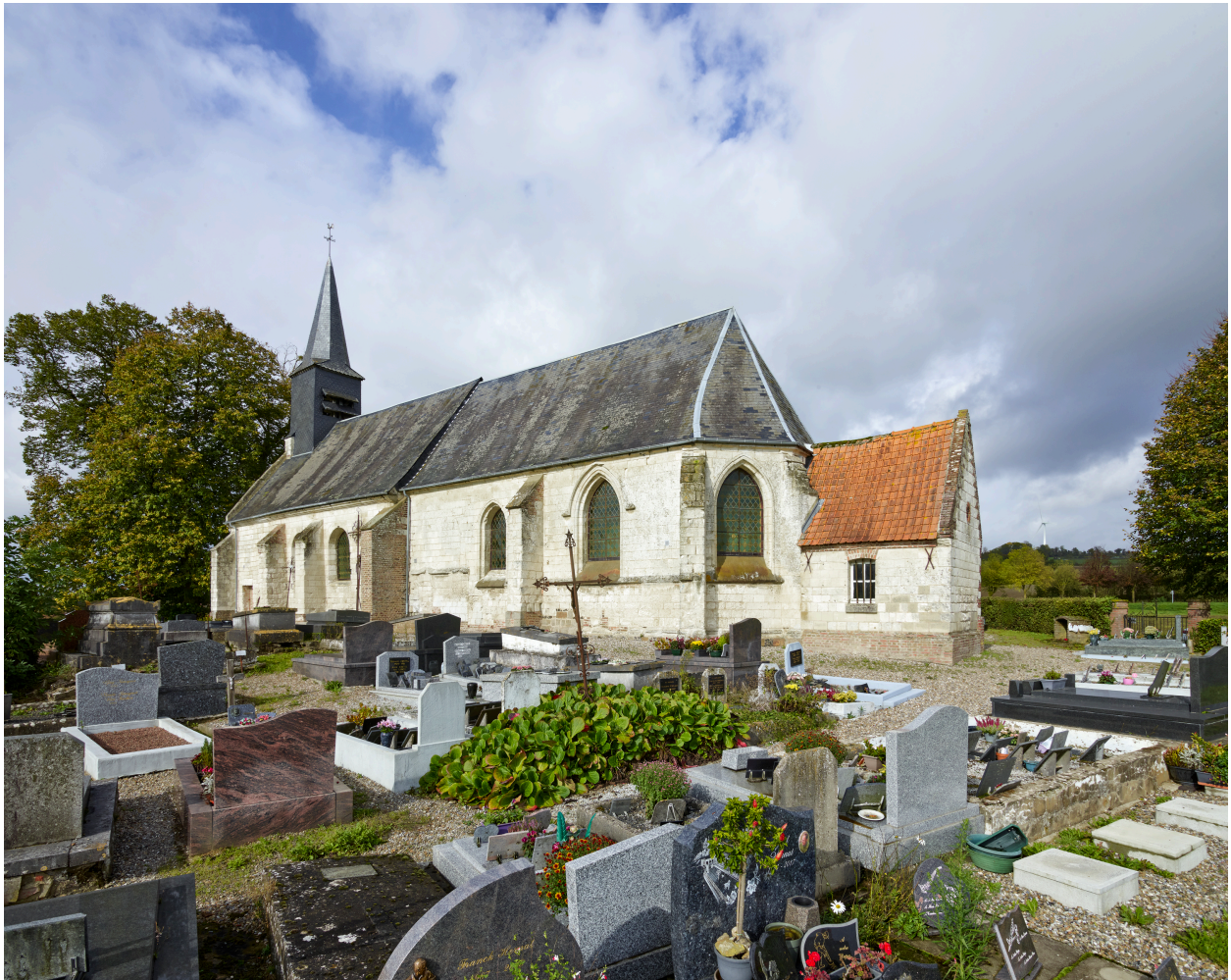
Vue d'ensemble de la sacristie et de l'église, depuis le sud-est.
