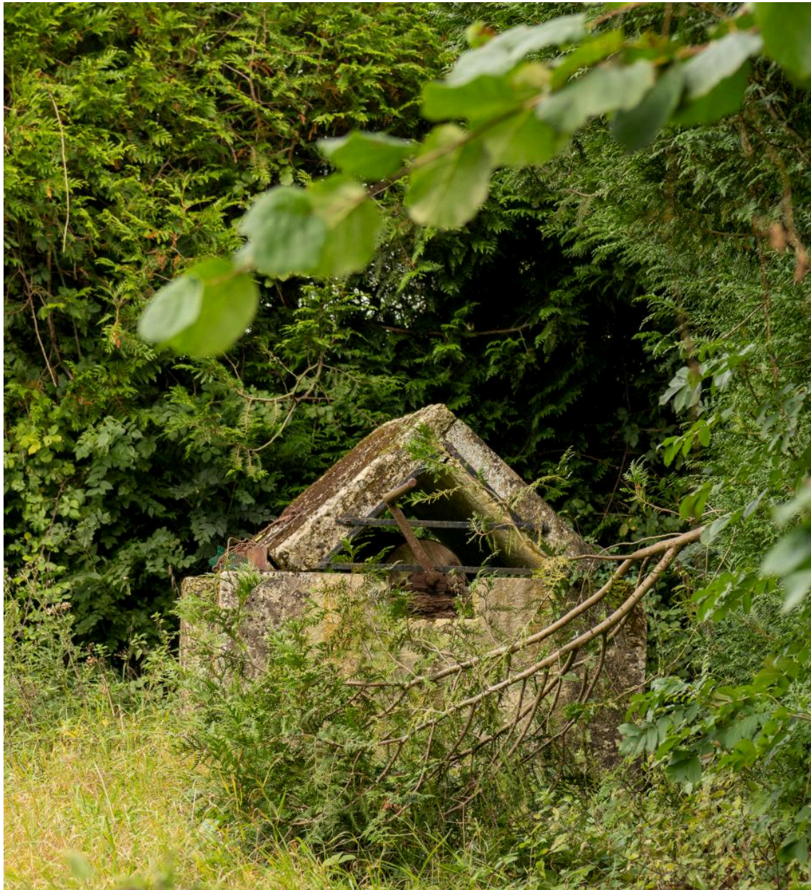
Puits rue du Pressoir avec ses maçonneries anciennes en pierre de taille calcaire, en face du n°14.
