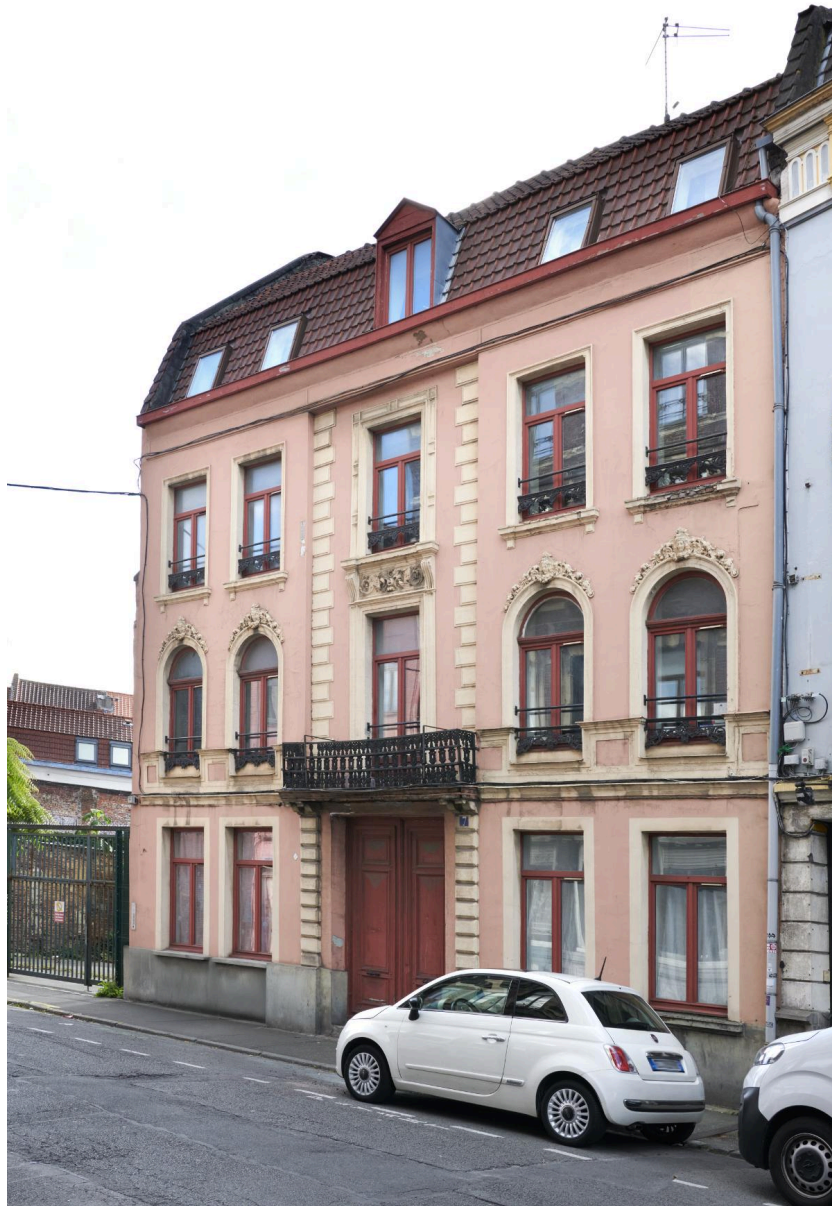
Vue générale de la façade.
