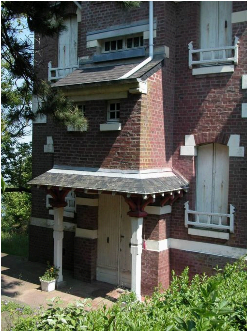
Détail du porche d'entrée.
