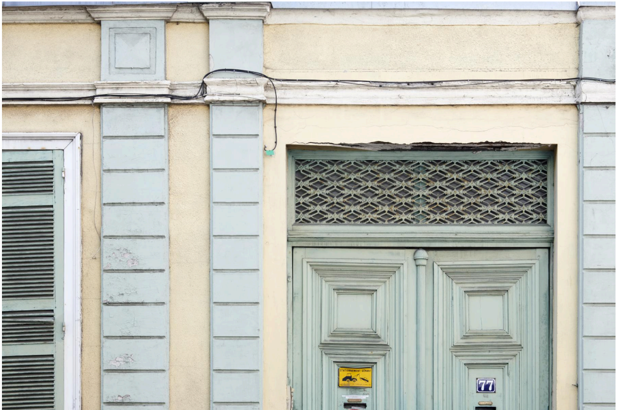
Détail de l'annexe : garage, ferronnerie et pilastres.
