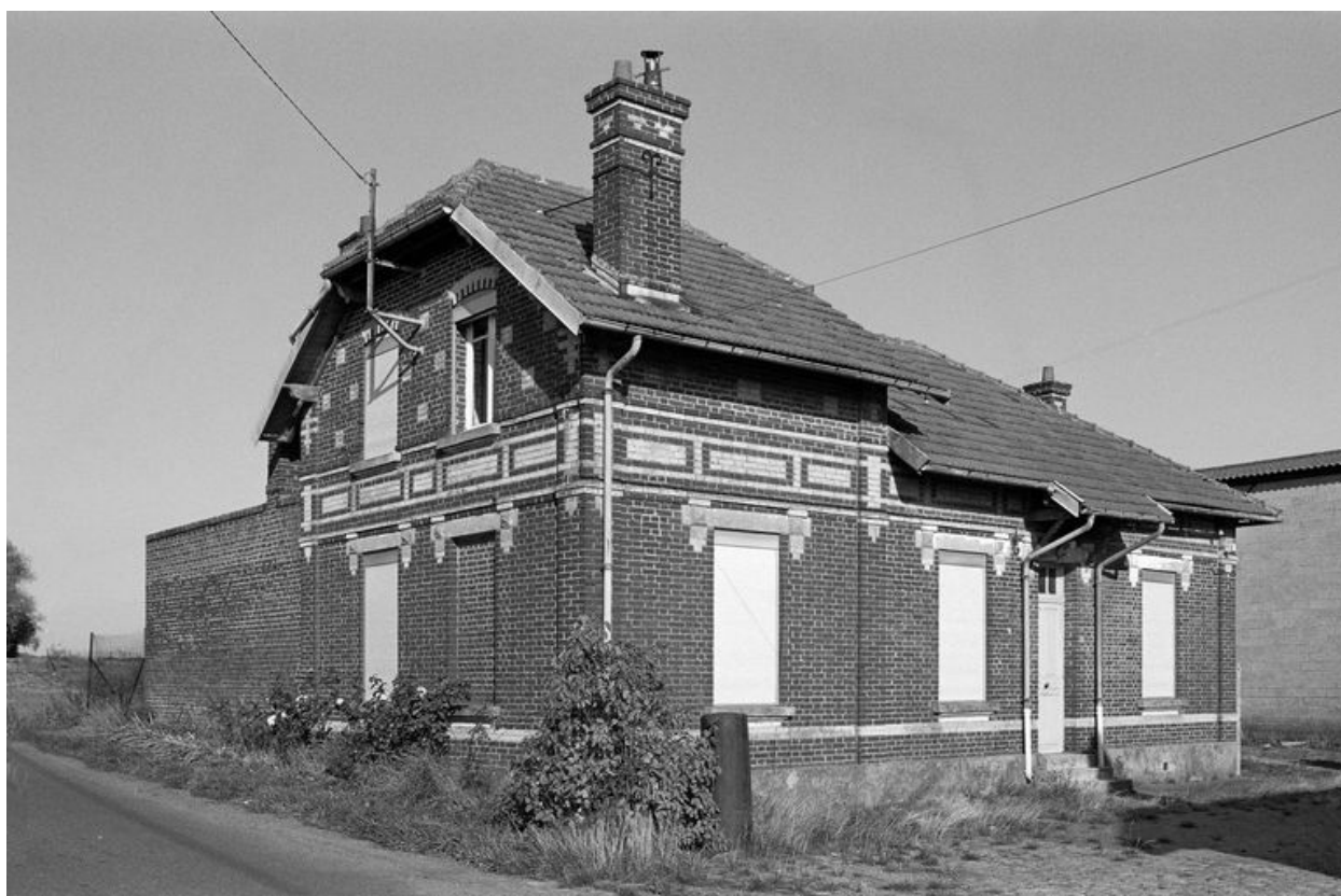
Logement de contremaître : flanc sud-ouest.
