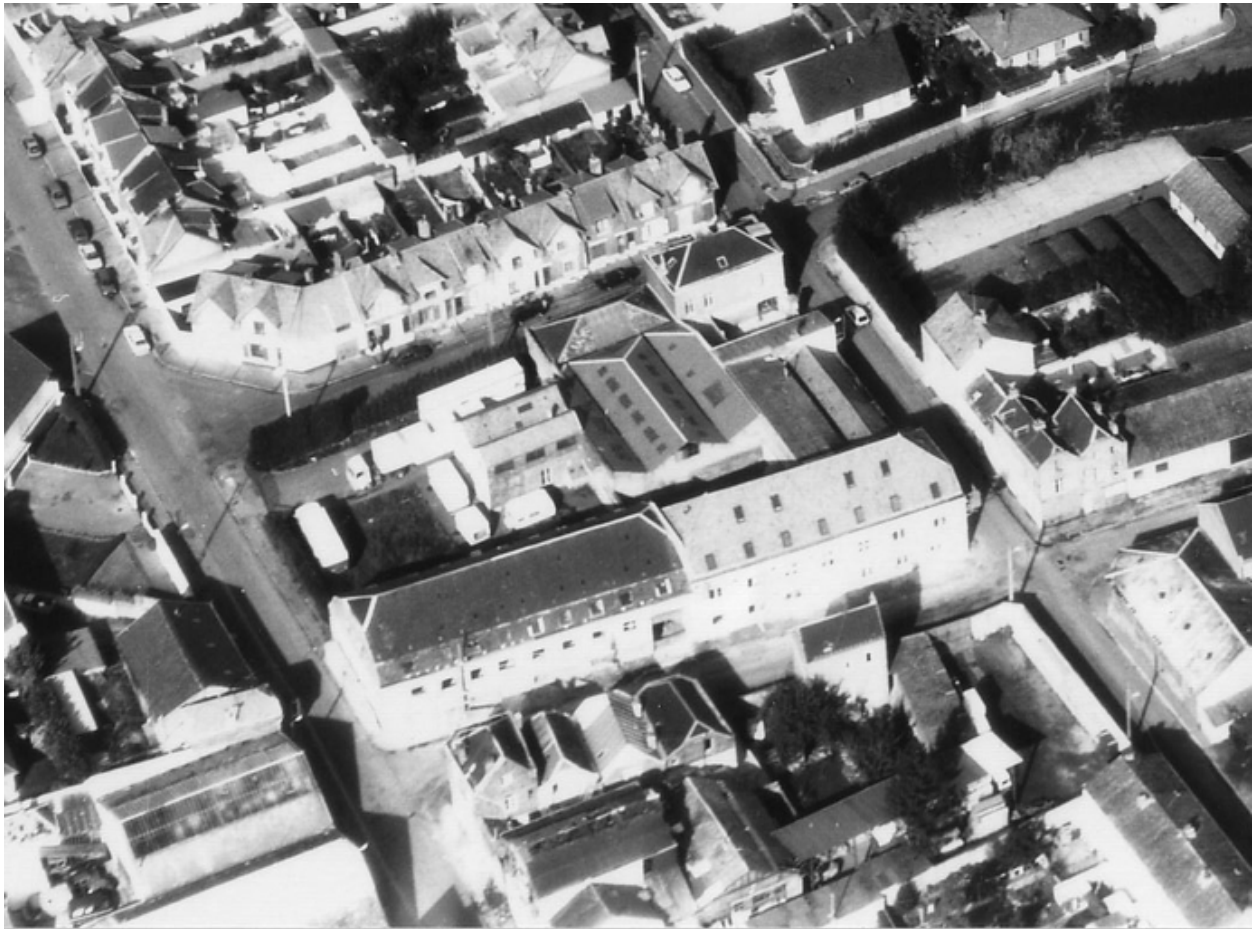
Vue aérienne du site de l'ancienne usine d'apprêt et de blanchiment, 1989.
