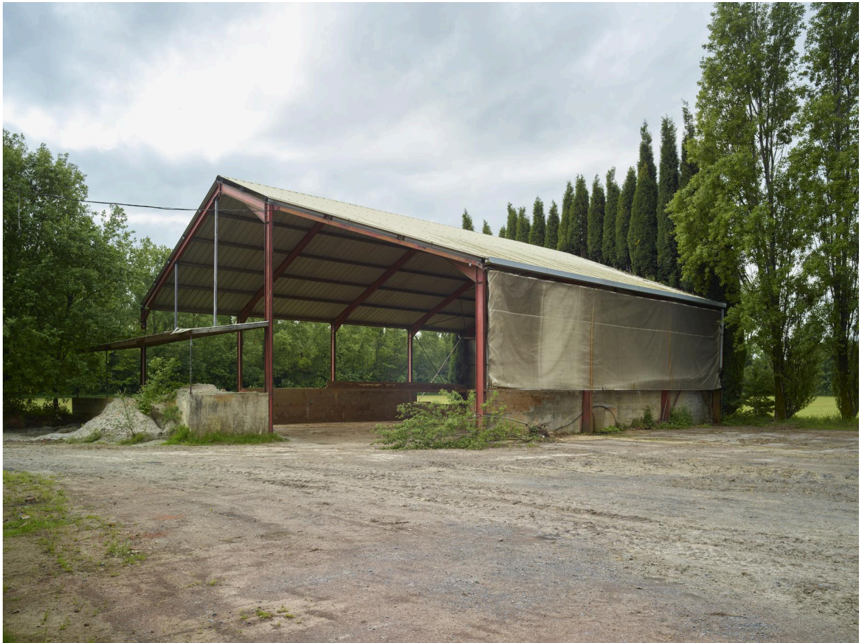
Hangar de stockage de l'argile.
