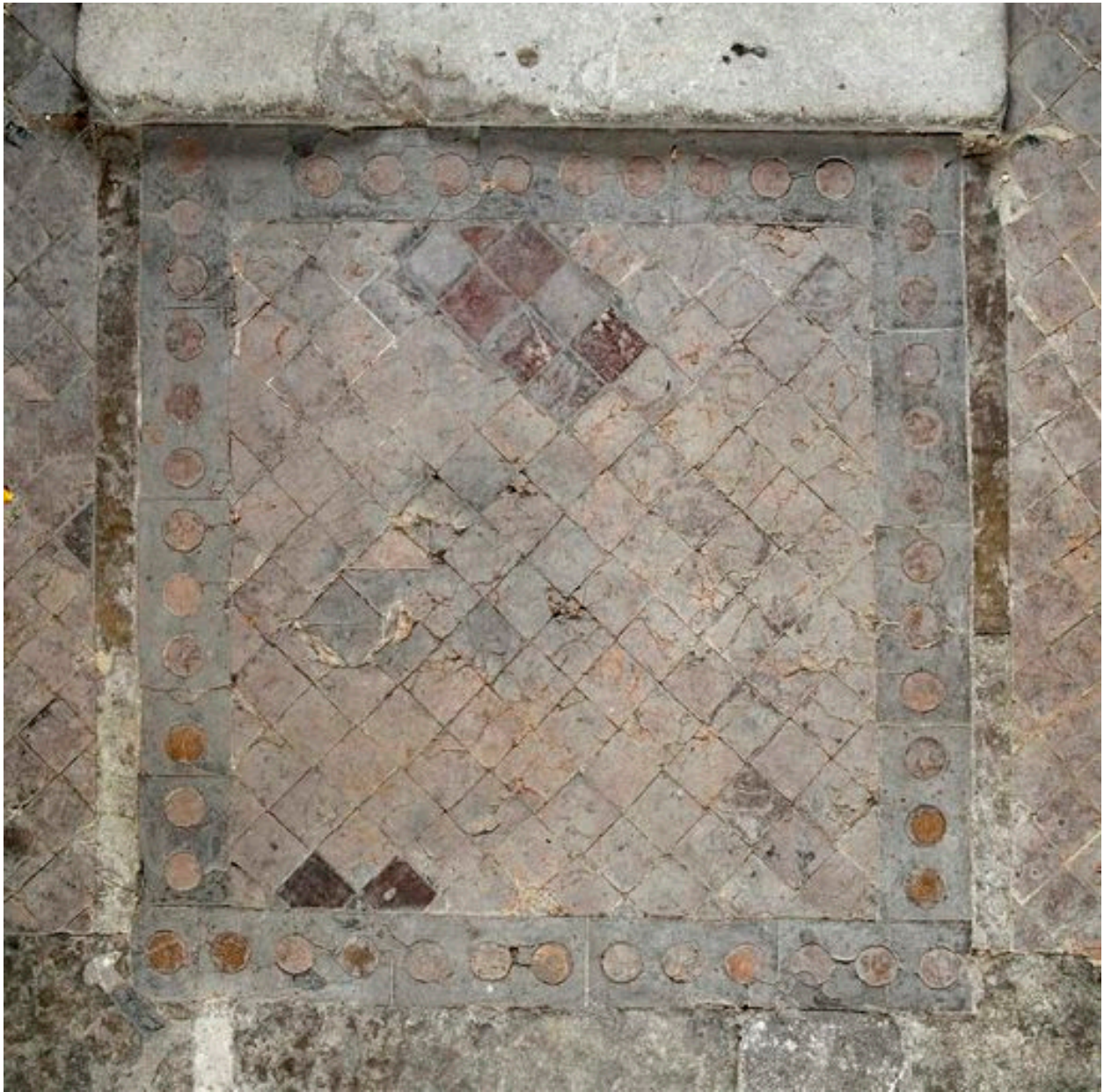
Détail du carrelage.
