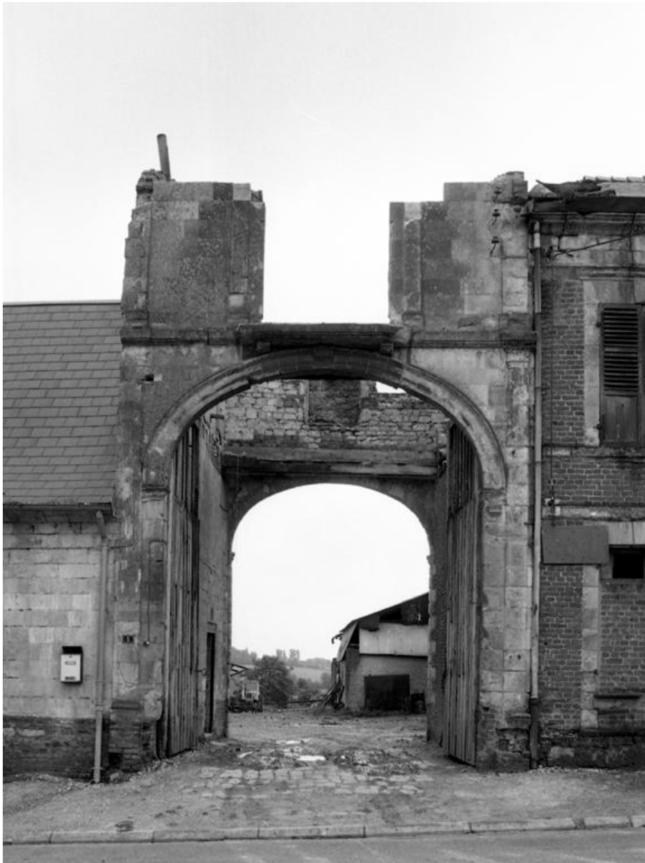
Vue de la façade du pigeonnier porche.
