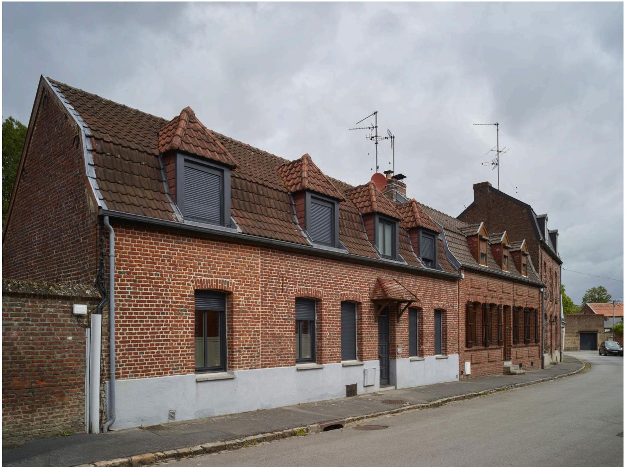
Maisons d'un seul niveau avec combles - troisième quart XIXe siècle - 6 et 8, rue de Turenne.
