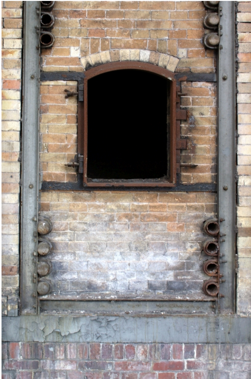
Vestiges de l'une des deux chaudières de la chaufferie.
