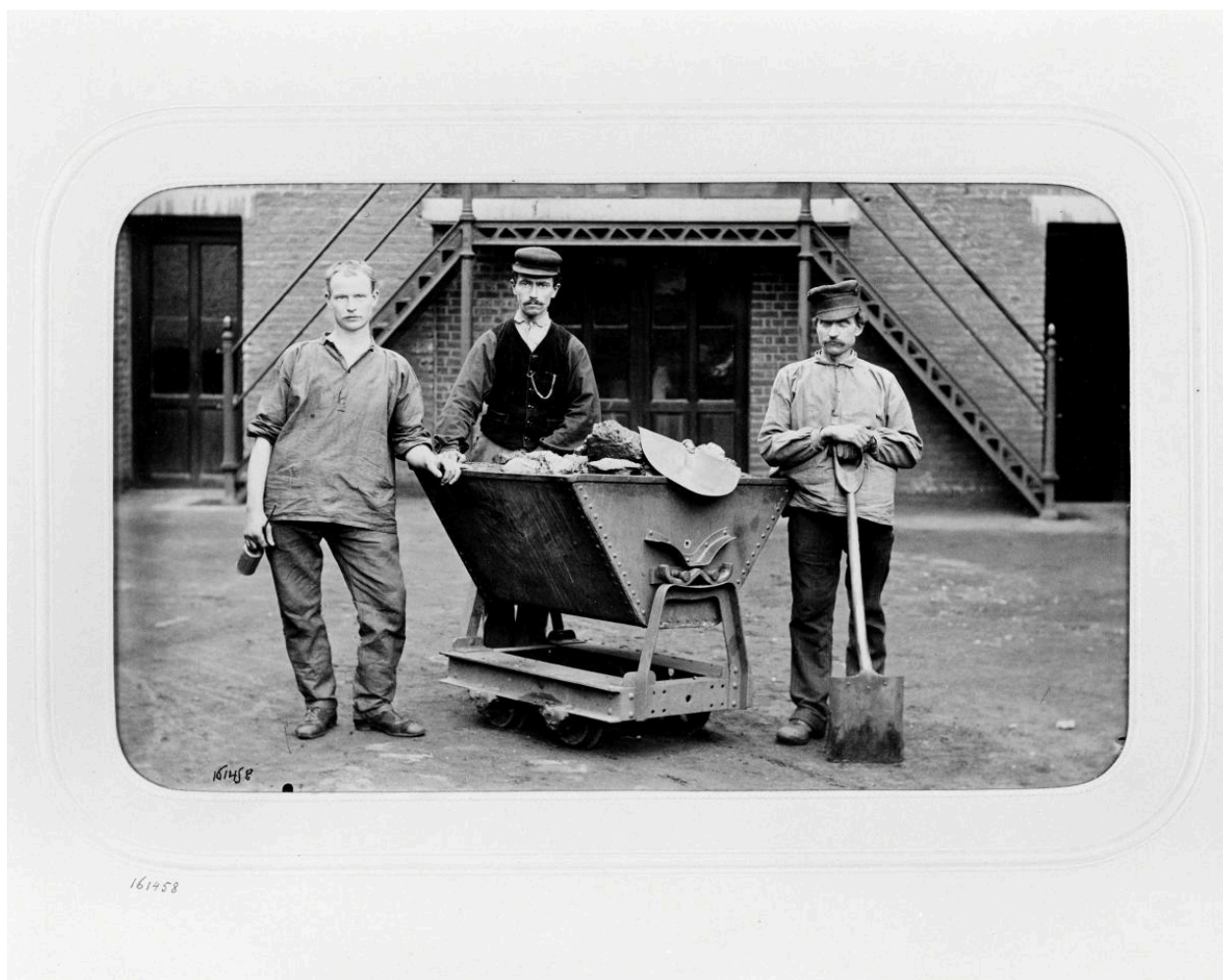
Chauffeurs de chaudières. Photographie de J. David, 1897 (AP Hacot et Colombier).
