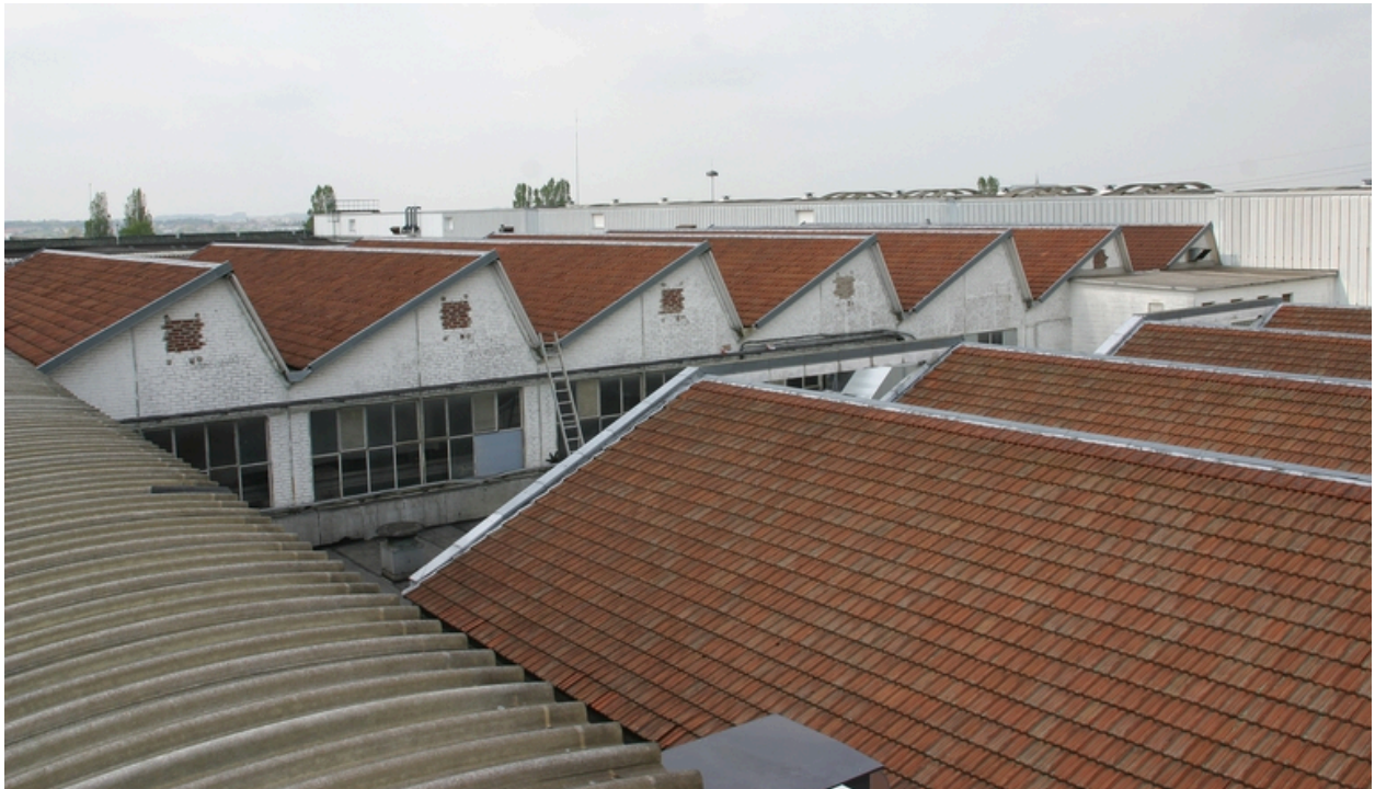
Sheds des ateliers de 1929 (à droite) et des ateliers de 1962-1963.
