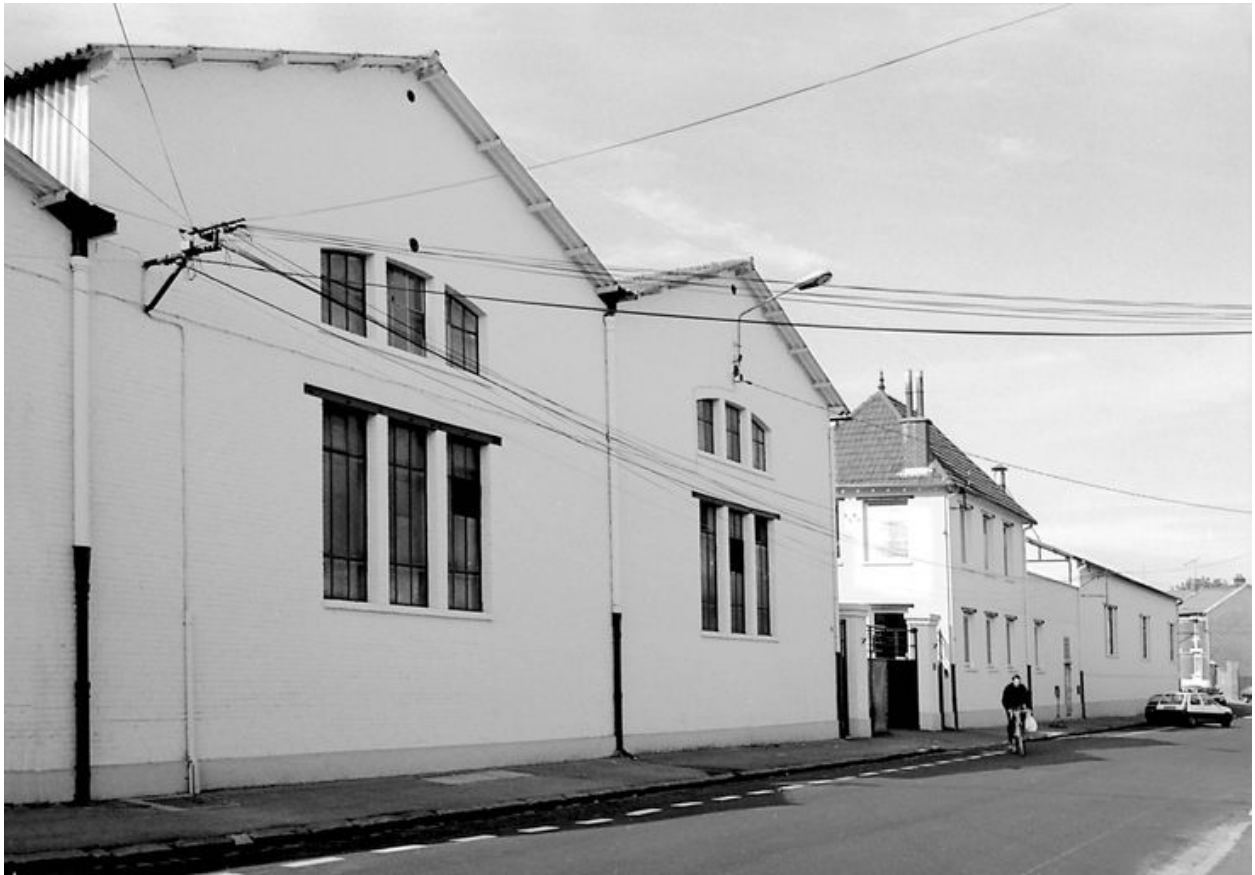
Vue partielle, flanc est.
