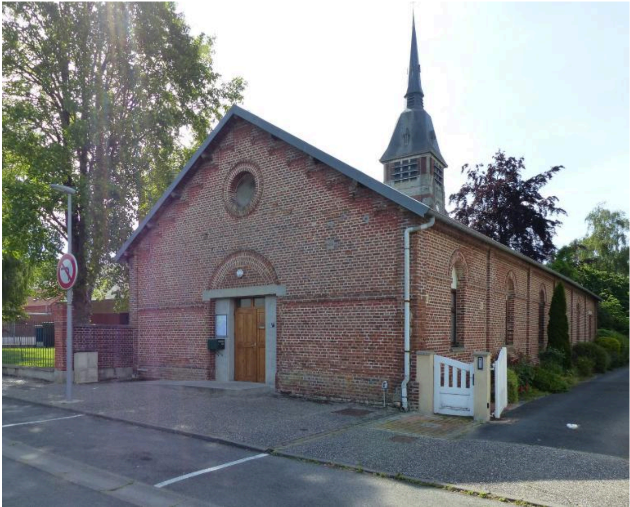
Vue générale, depuis le nord-ouest.
