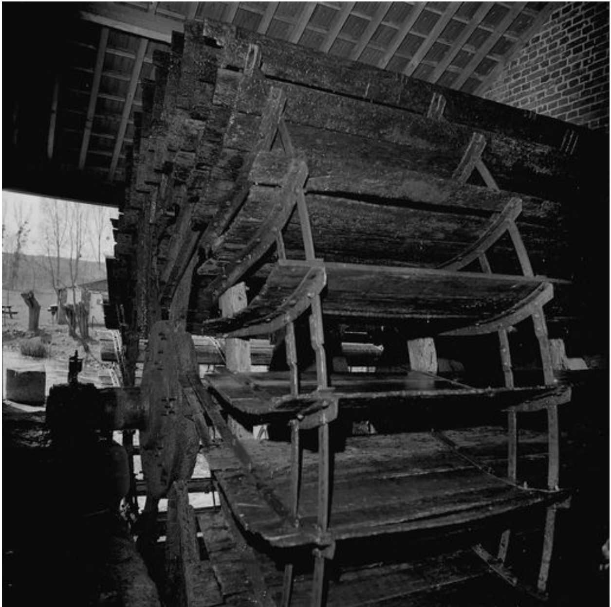
Vue de la roue hydraulique dans sa cage.
