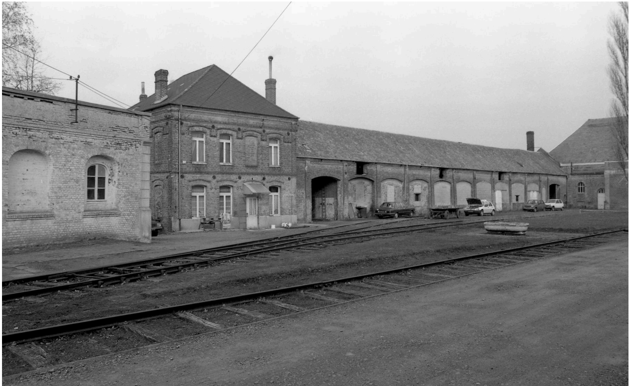
vue d'ensemble sur cour des magasins à charbon et du logement attenant, en 1989.
