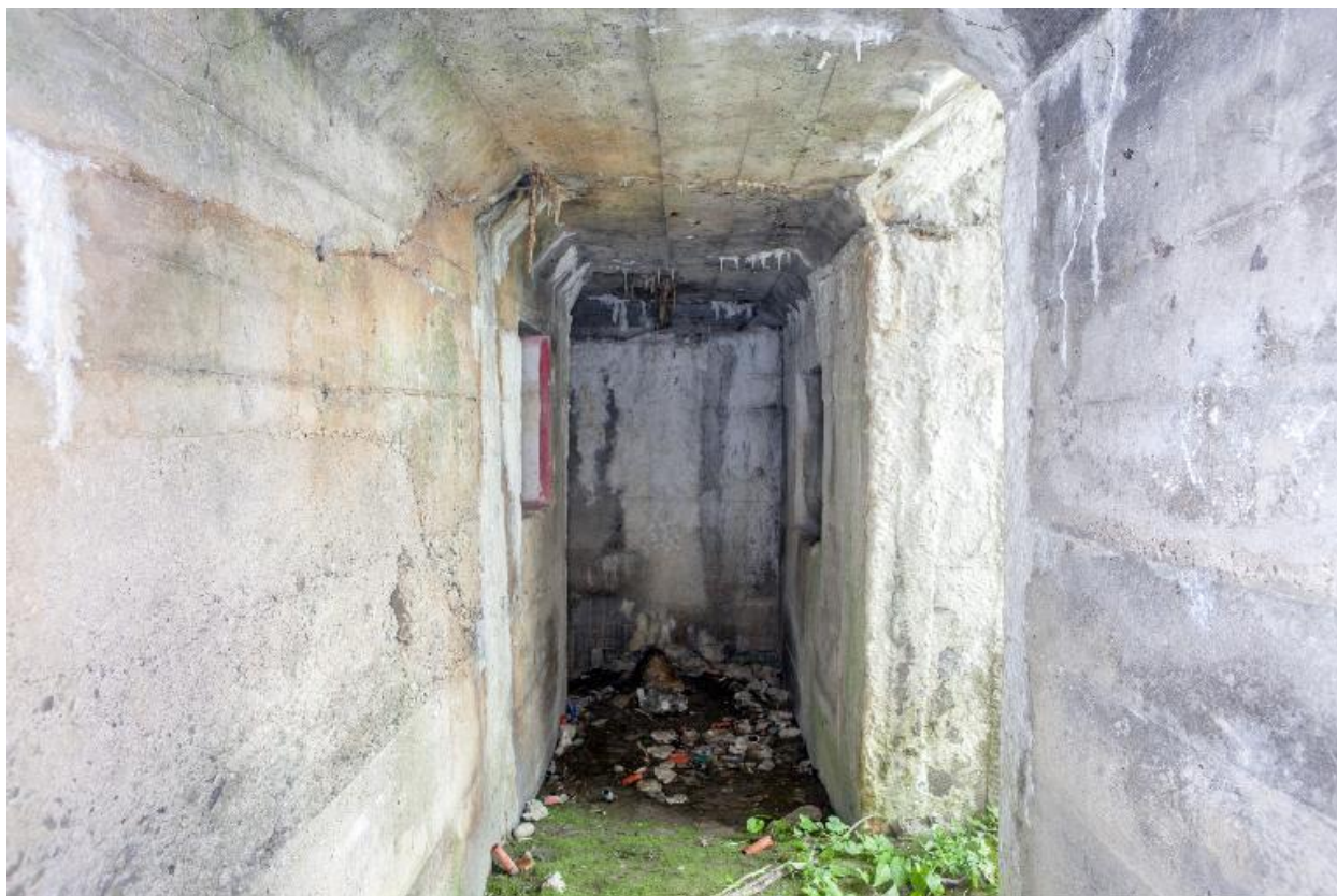
Couloir de distribution, vers l'est
