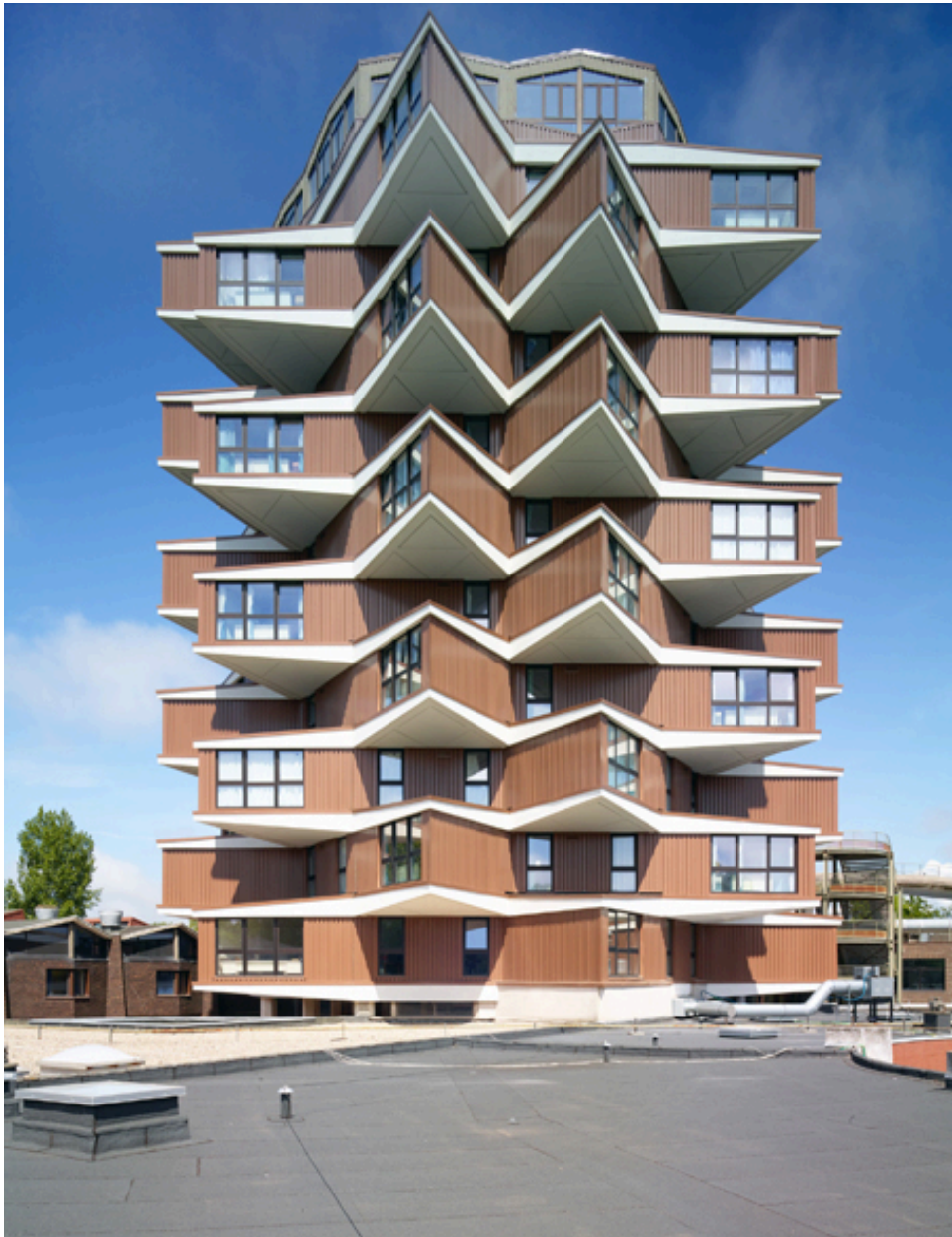
Vue rapprochée de l'élévation sud ouest de la tour de l'internat, depuis la toiture du C.E.T.
