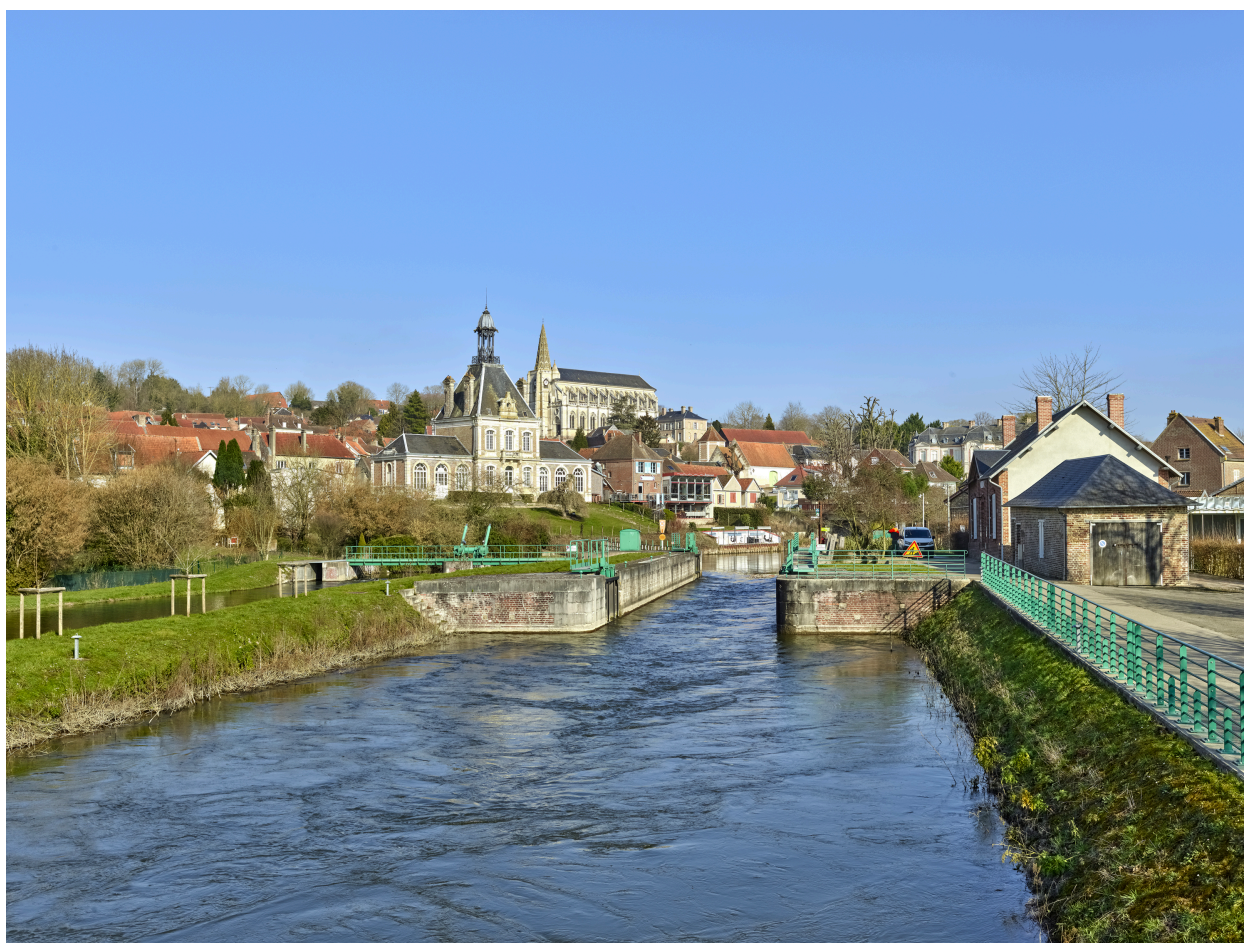
Vue de l'écluse, depuis l'ouest.
