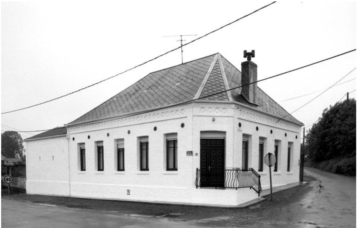
Vue d'ensemble de la façade.
