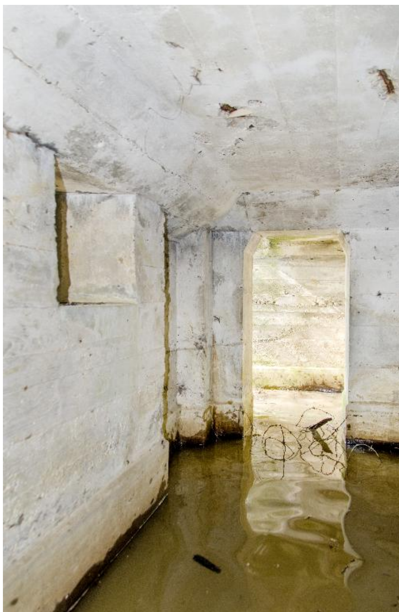
Vue intérieure vers l'entrée ouest
