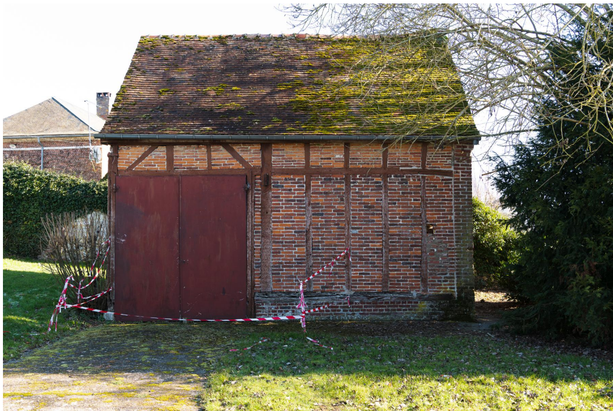
Grange, rue Mariette, vue depuis l'ouest.
