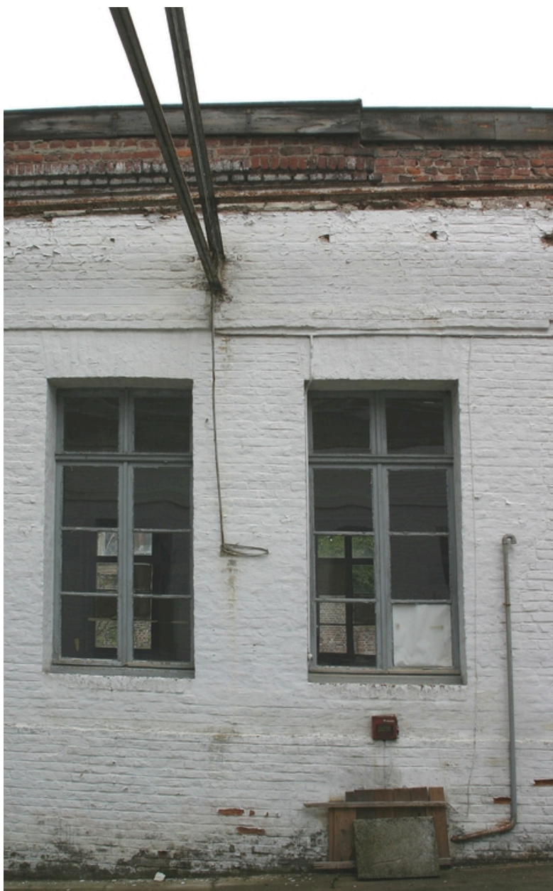
Détail de deux travées de la façade sur cour des ateliers de 1861.
