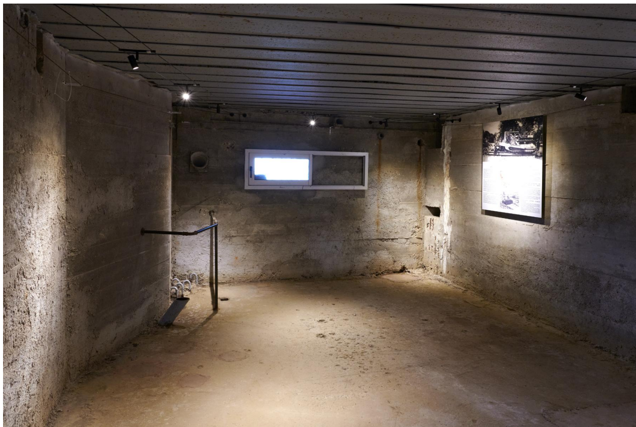
Seconde chambre de tir avec créneau anti-char 25 mm (ouverture rectangulaire).
