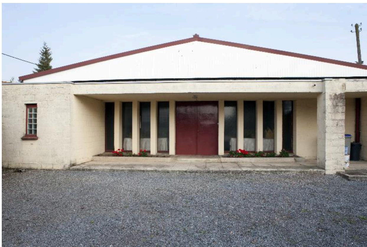
Élévation antérieure de la chapelle.
