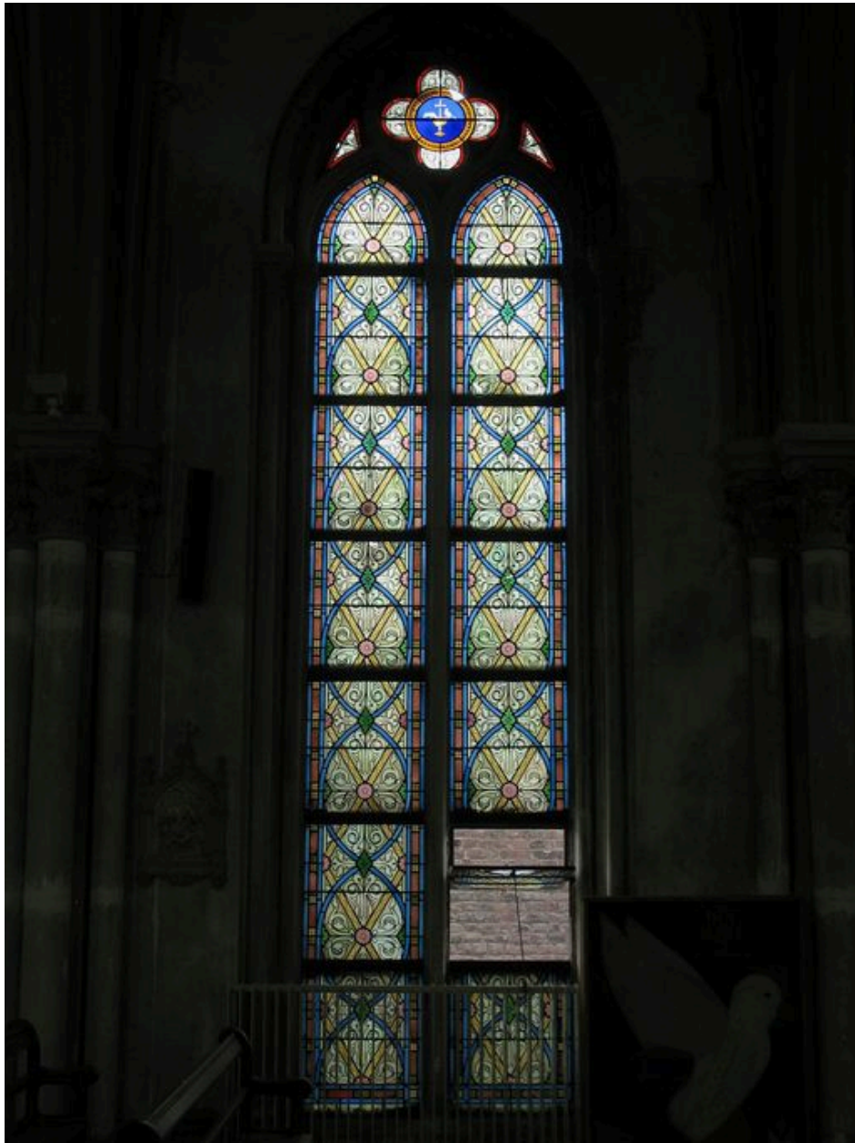
Vue générale, baie 13
