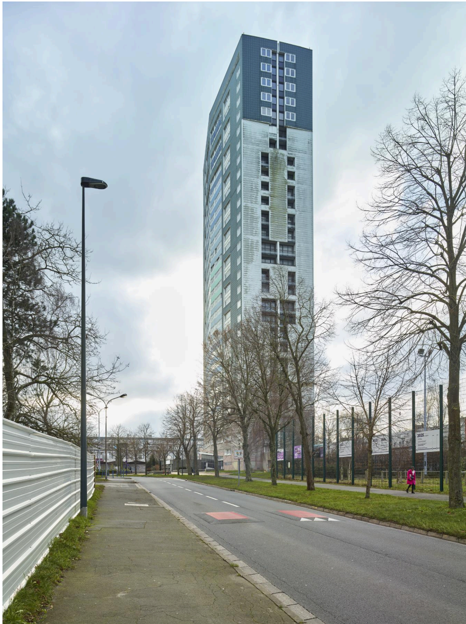
La façade nord et l'angle nord-est, depuis la rue de la Paix.
