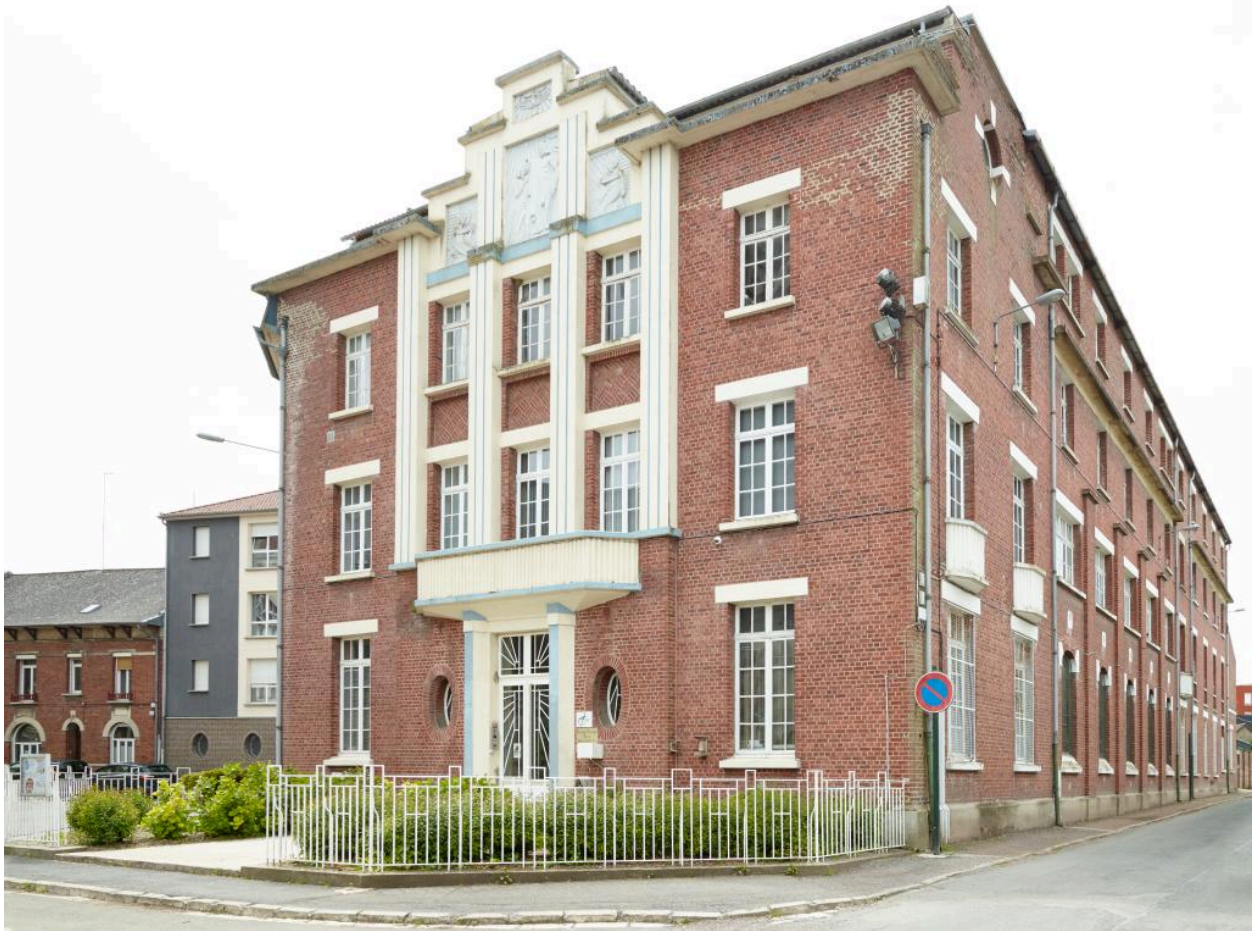
Vue générale sur la façade place de l'église et la façade rue des casernes.
