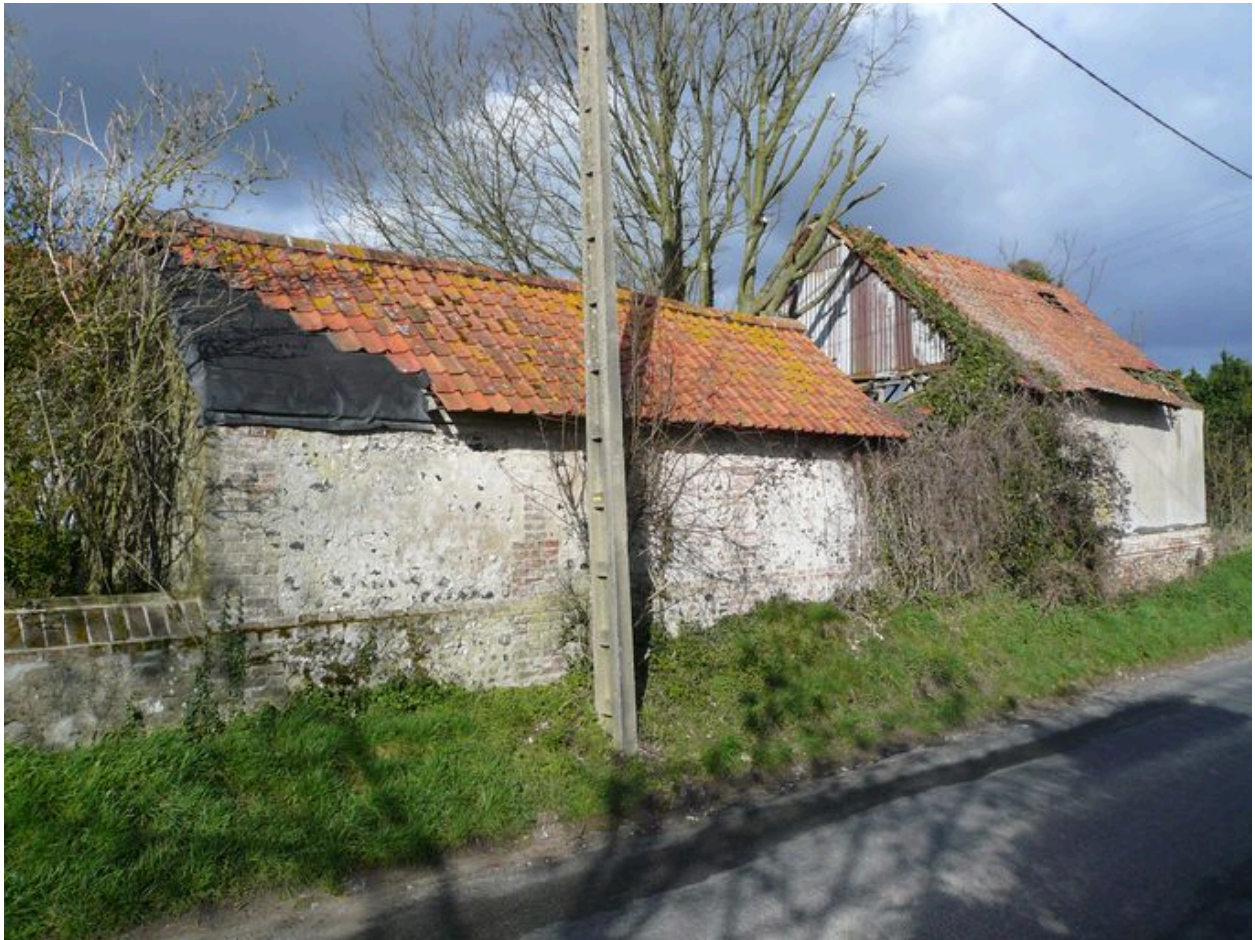
Vue des bâtiments sur rue.
