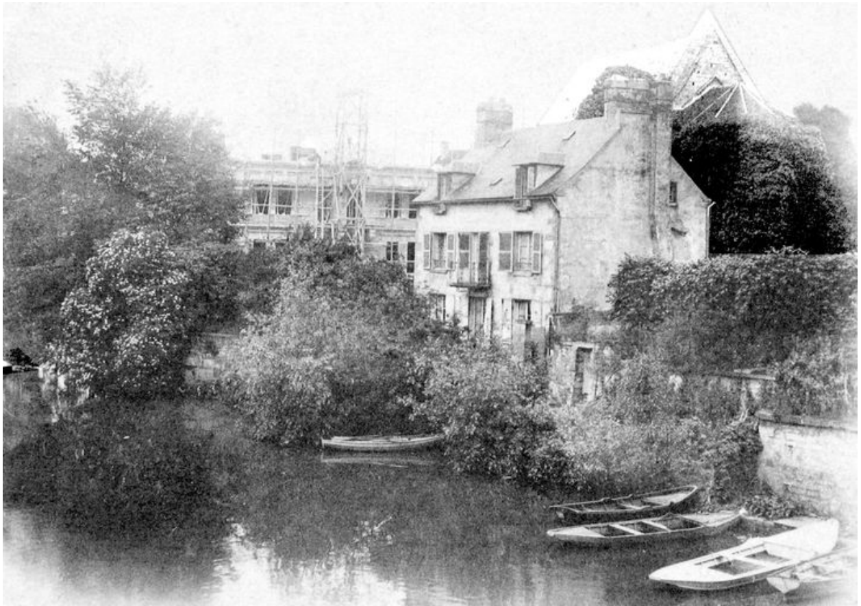
L'île Saint-Maurice : l'hôtel de ville en construction et la collégiale à droite envahie par la végétation (AC Creil).
