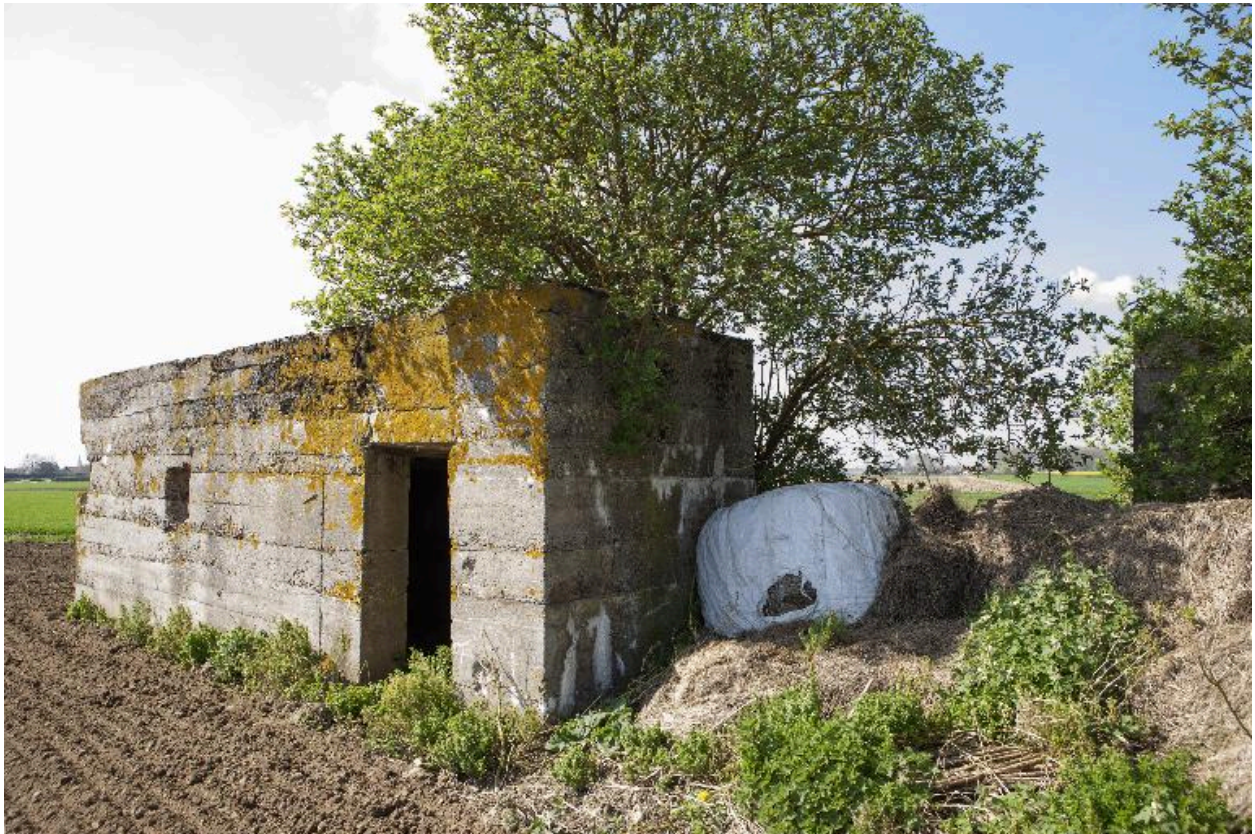
Bâtiment 1 : L'entrée sur élévation ouest
