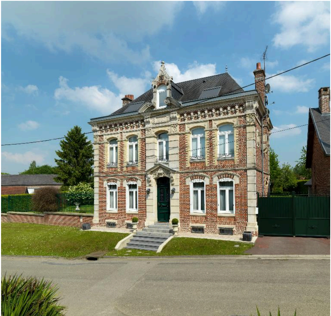
Vue d'ensemble sur rue.
