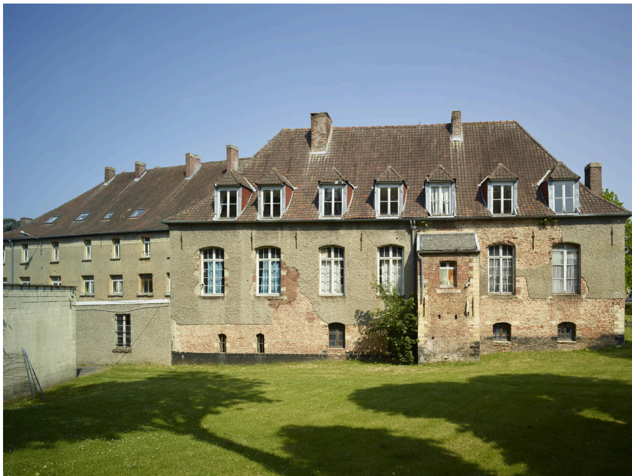
Caserne Cernay : vue générale de la façade arrière.
