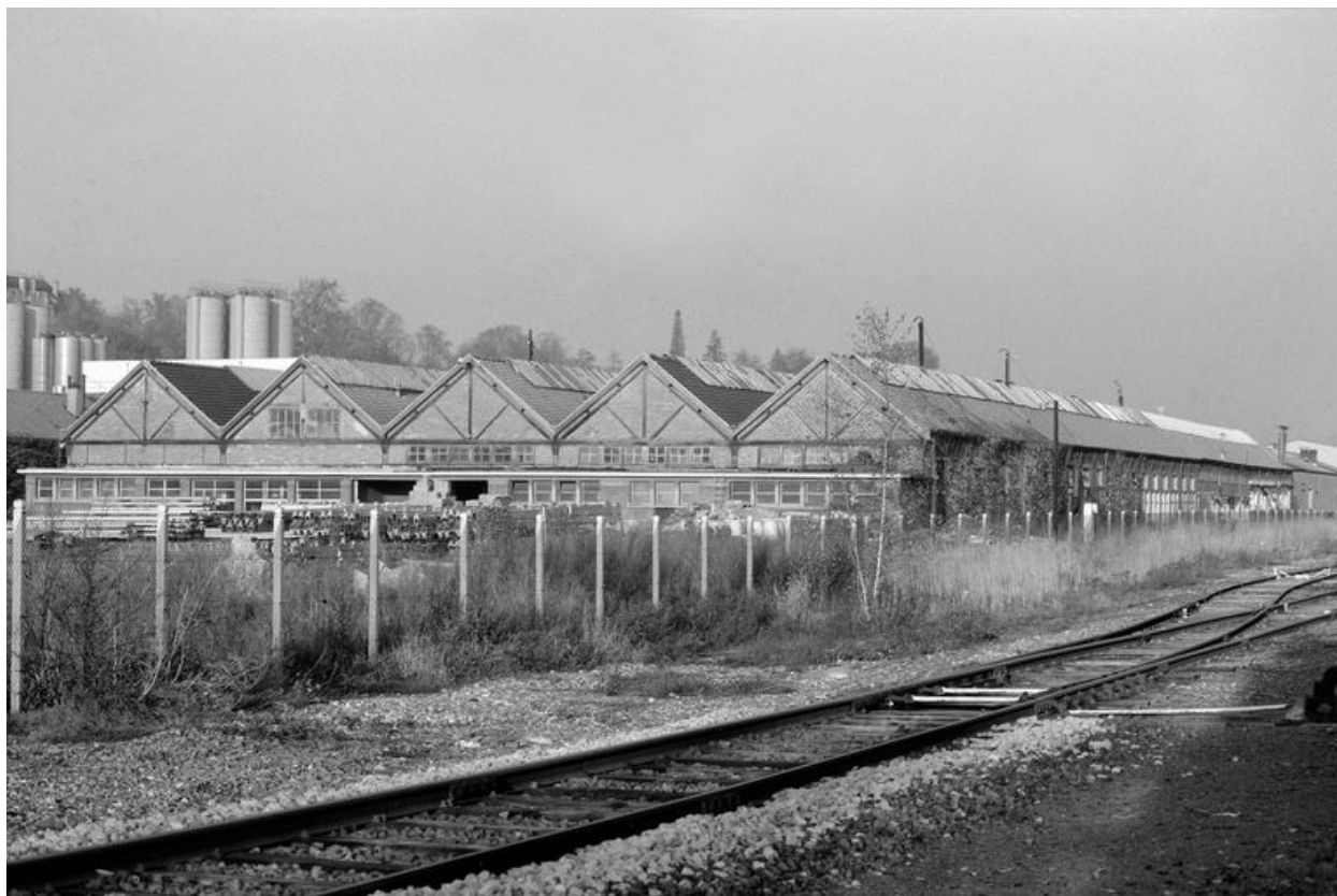
Atelier de fabrication (ancien chemin de la Ville le Marcelet), en 1987.
