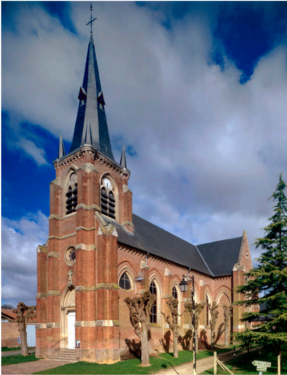
Façade antérieure et latérale est.
