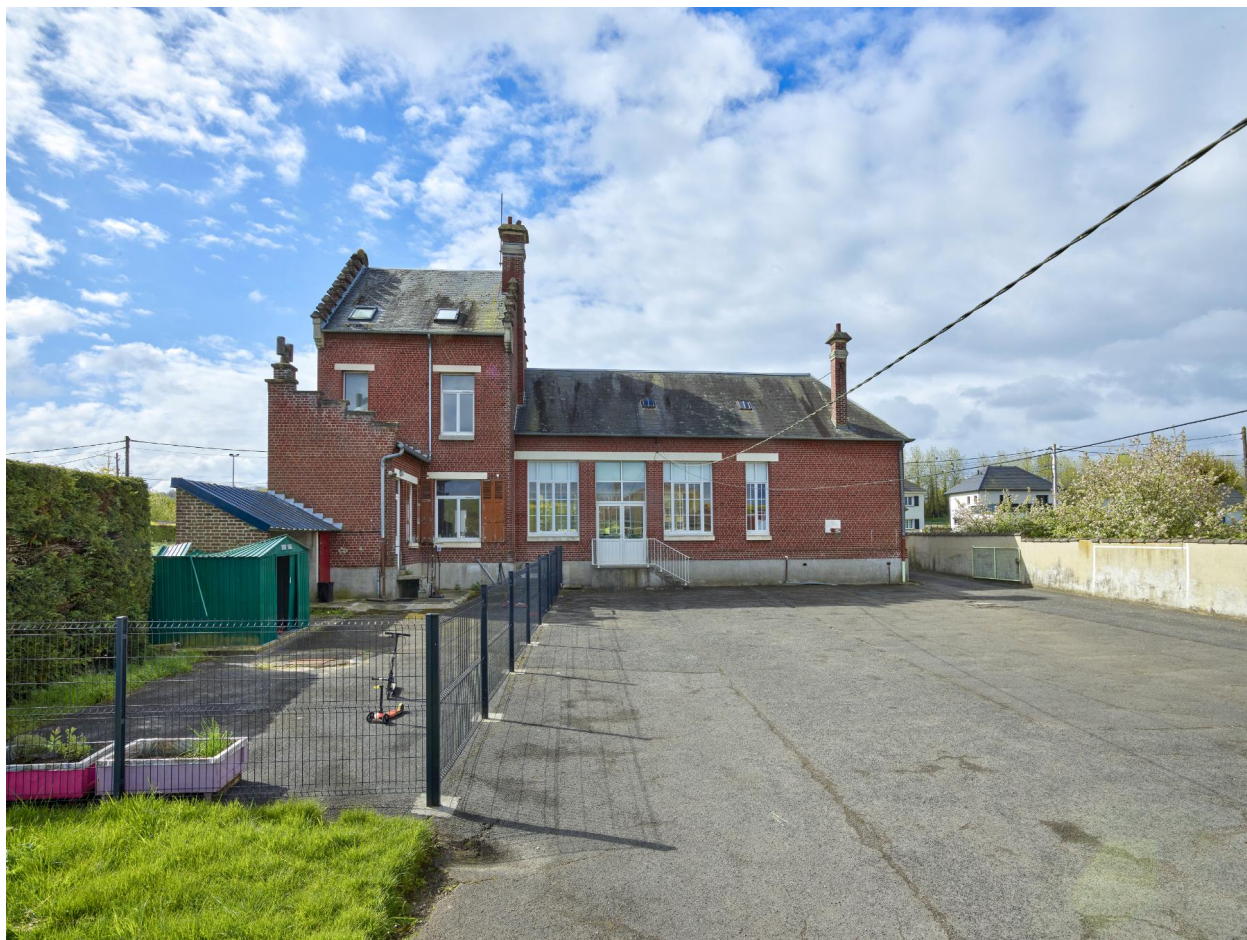
Vue de la mairie, de la garderie et de l'ancien logement de l'instituteur, depuis le nord.
