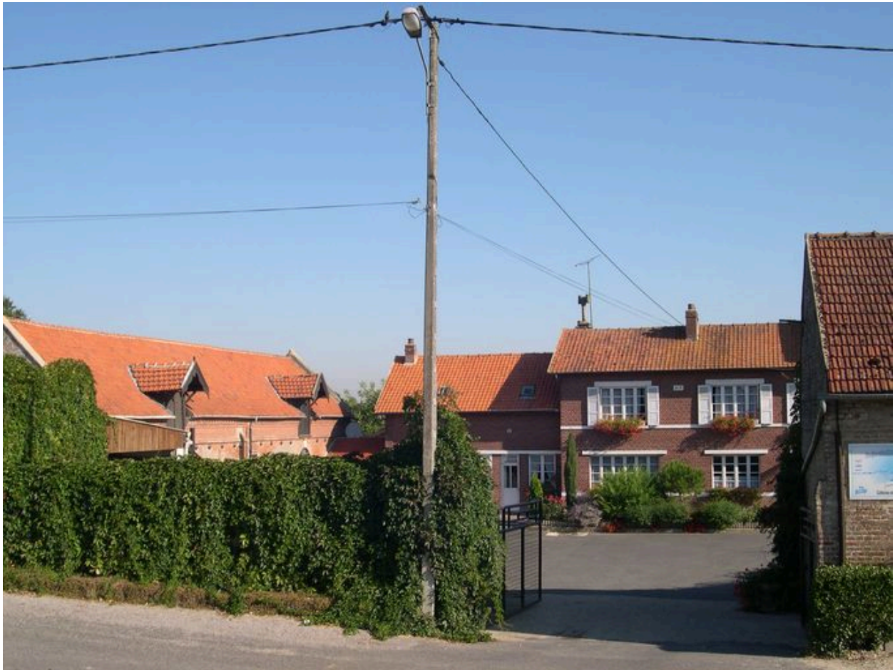
La ferme du château, vue du sud-est.
